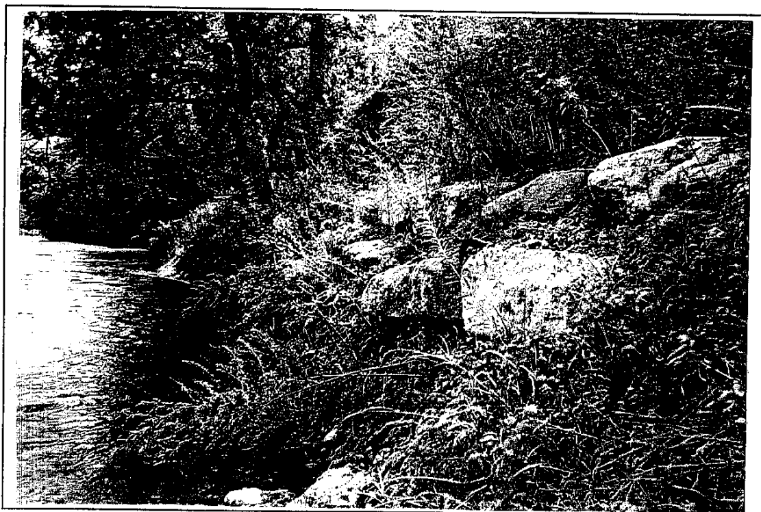
Fig. 4.3 – Spezzoni di massicciata lungo la riva destra dell'Adda a sud della centrale Esterle.
