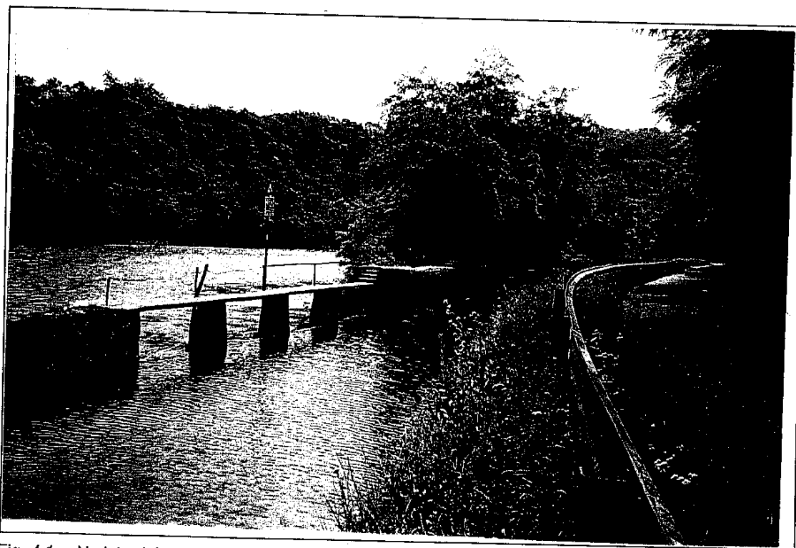
Fig. 4.1 – Veduta del F. Adda e del Naviglio di Paderno a nord-est di Porto d'Adda. Si può apprezzare la differenza di quota esistente tra il pelo libero del fiume rispetto a quella del canale artificiale.
