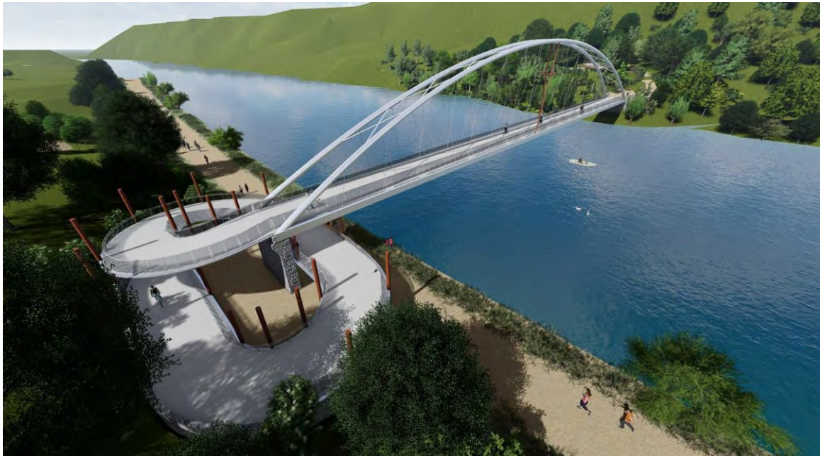
Particolare della rampa di accesso ciclo pedonale nel comune di Cornate d'Adda
